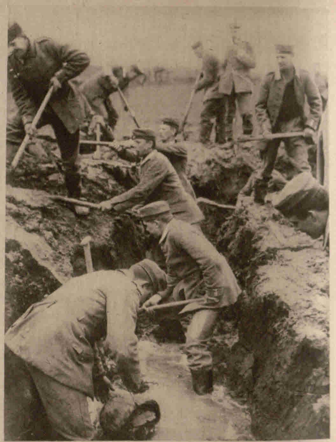
Zur Befestigung Memels gegen erneuten Russeneinfall: Ausheben von Schützengräben, in denen das Wasser stellenweise sehr hoch steht Phot. L. Pr. B.
