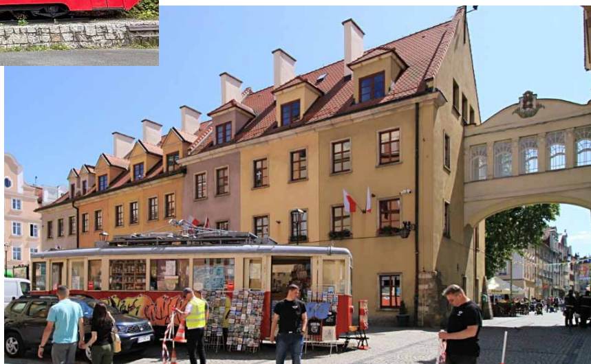
Tramwaj jako punkt informacji turystycznej na rynku w Jeleniej Górze. Pod łukiem łącznika jako pamiątkę historyczną zachowano fragment torów tramwajowych.
