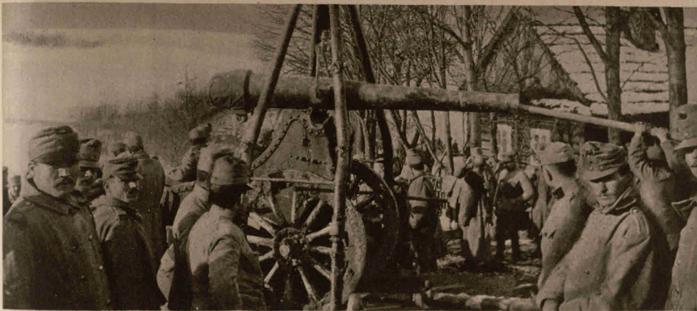
Ein österreichisches Geschütz wird in den Karpathen montiert
