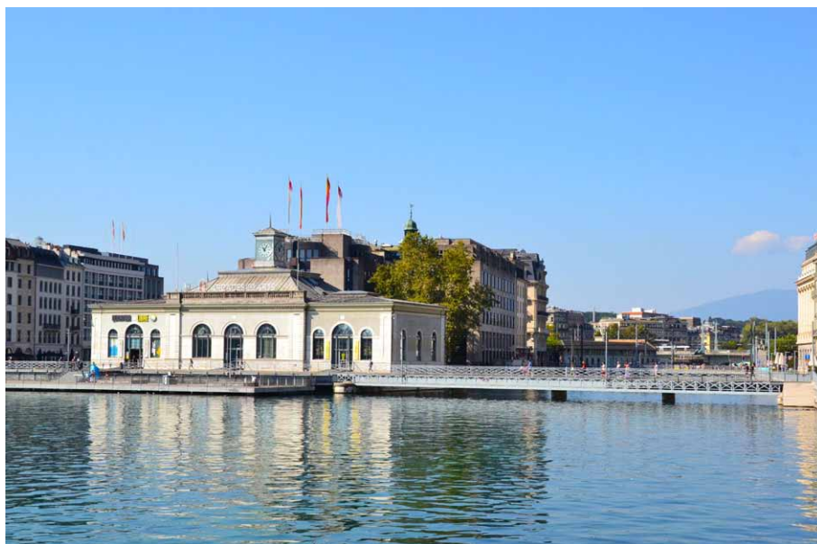
Pont de la Machine i budynek „Machiny” od strony jeziora
