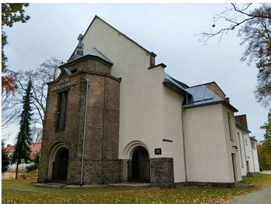
Budynek Lutherkirche Hirschberg – Cunneredorf in Risengeb. (1930-35 r.)
