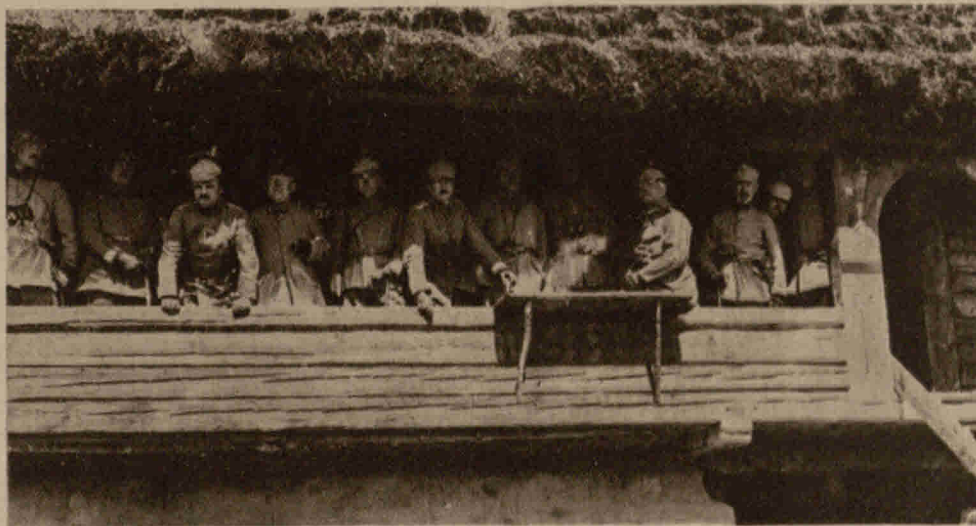
Erzengel von Conta mit seinem Stabe in einem Bauernhause in den Westiden Bild über das Kampfgelände Ostro-Twinin
