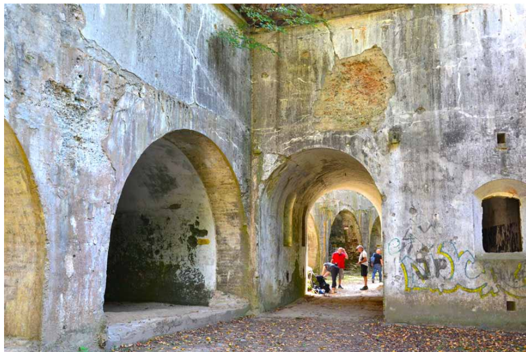
W betonowych wnętrzach fortu „Salis Soglio”
