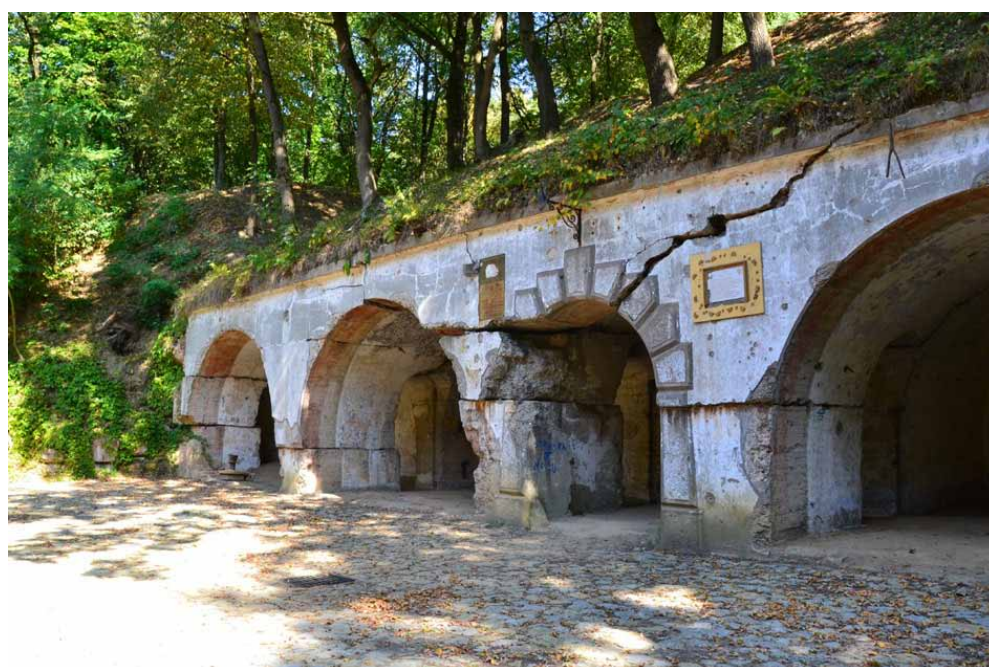
Fort „Salis Soglio”, przejście z dziedzińca sztyjowego w głąb fortu
