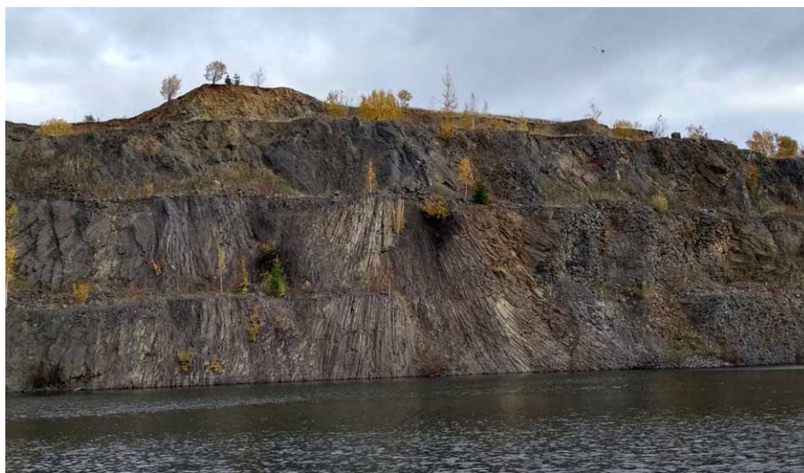
Kamieniołom na wschód od Kłopotnicy, pęknięcia w bazaltowej ścianie
