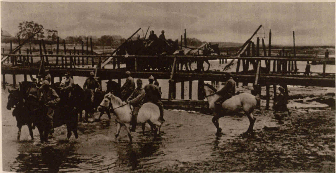
Oesterreichisch-ungarische Kavallerie im Zug an der niedergebrannten Brücke vor Sokal. Die neue Brücke wurde von den Oesterreichern erbaut.
