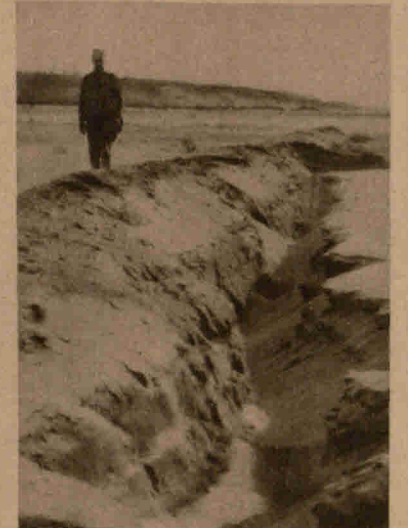
Schützengräben in den Dünen am Ufer der Weichsel
