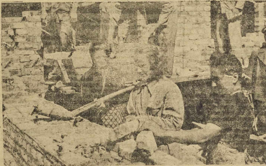
Kobiety biorą czynny udział w odbudowie Wrocławia. Nie brak ich również przy pracy murarskiej
