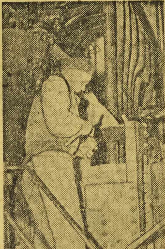
Ozorkowski przemysł bawełniany rośnie. Na ukończeniu jest budowa wielkiej wykończalni i elektrowni zakładowej. Na zdjęciu — przodujący murarz, Stanisław Asman, zajęty przy obmurowaniu kotłowni w elektrowni zakładowej. CAF — fot. Dąbrowiecki
