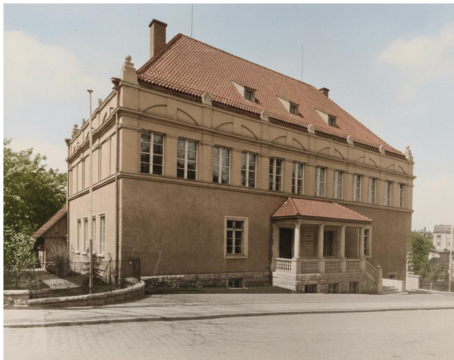
Rys. 11. Widok na budynek Muzeum w 1914 roku.
