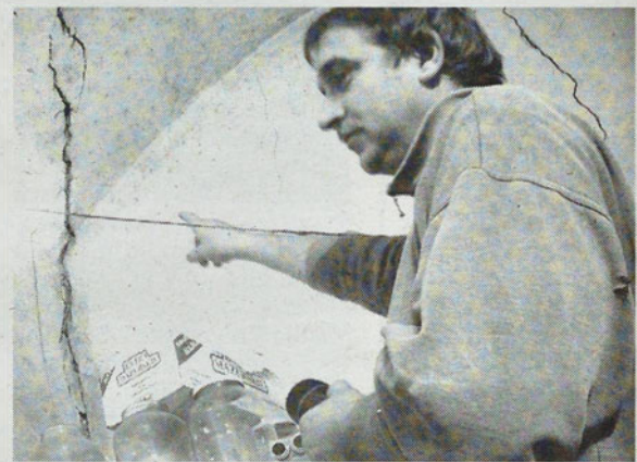
Krystyna Szot (na zdjęciu jej brat Marek) nie przesadzała. Pęknięcia mają kilka centymetrów
