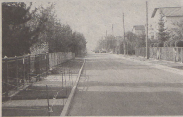
W zeszłym roku przebudowano wiele dróg, m.in. ul. Okrzei w Kątach Wrocławskich
