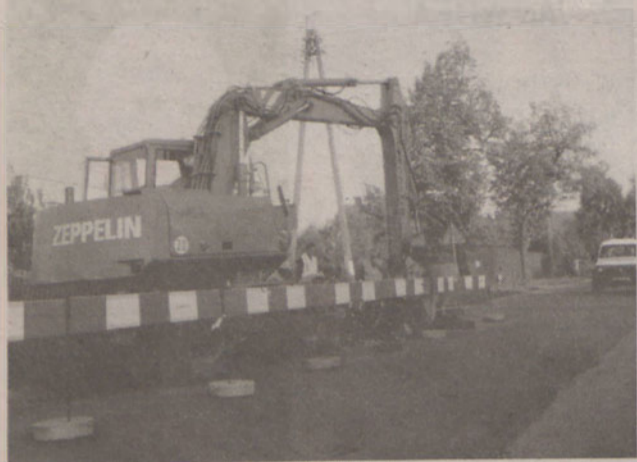
Drogi są remontowane w wielu miejscowościach
