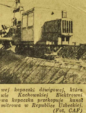
U GÓRY: montowanie 25-tonowej kopaczki dźwigowej, która będzie pracowała na budowie Kachowskiej Elektrowni Wodnej. Poniżej: wielocerpakowa kopaczka przekopuje kanał trygacyjny w kolchozie im. Dymitrowa w Republice Uzbekkiej. (Fot. CAF)
