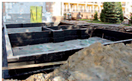
Fundamenty nowego budynku są wykonane do tzw. stanu zerowego, czyli sięgają do poziomu gruntu
