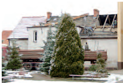
Poniemiecki budynek został wyburzony w ubiegłym roku
