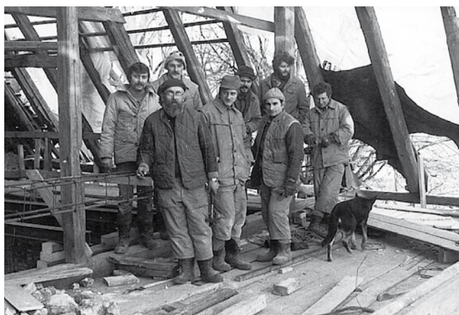
Odbudowa Dworu Czarne (archiwum)
