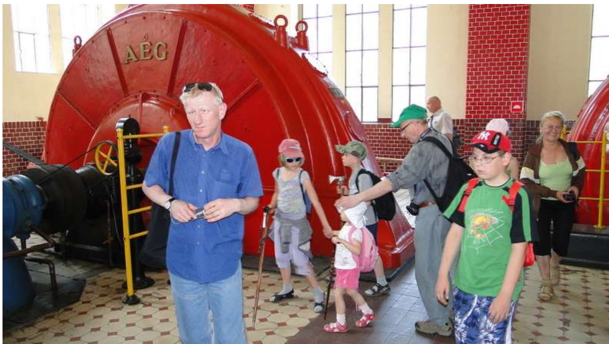
Elektrownia wodna w Pilchowicach. Foto: Krzysztof Tęcza
