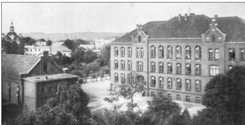
Ryc. 4. II Szkoła Ludowa i hala gimnastyczna (ibid., s. [53]).
