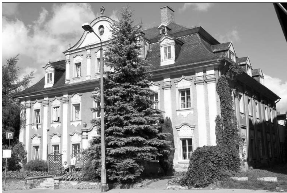
Ryc. 4. Budynek przy ul. Jagiellońskiej 2 w Jeleniej Górze-Cieplicach, do którego w latach 1957-1959 zamierzano przenieść muzeum (fot. Aleksander Nowak-Odelga)
