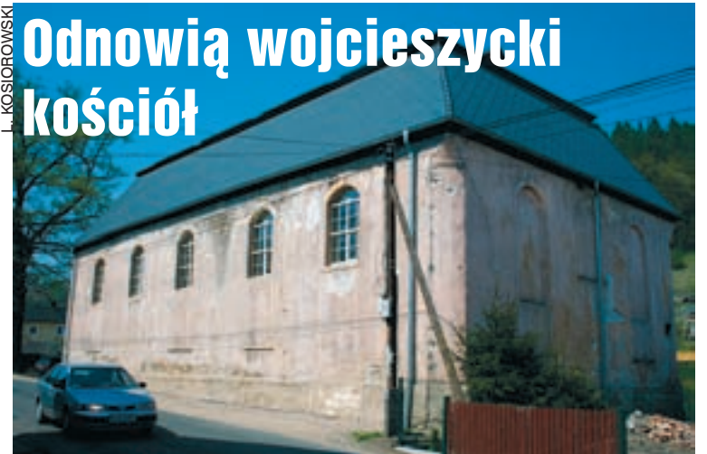
Elewacja kościoła w Wojcieszach zostanie odnowiona jeszcze w tym roku.
