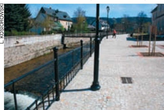
W ramach rewitalizacji starówki zniszczony teren nad Jedlicą zamienił się w ładny deptak.
