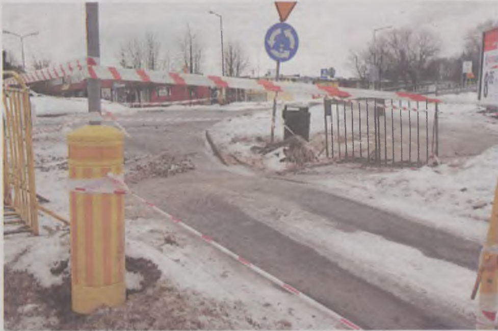
Zapada się droga przy zjeździe z alei Wolności na rondo. Od 30 grudnia połowa drogi jest zamknięta dla ruchu
