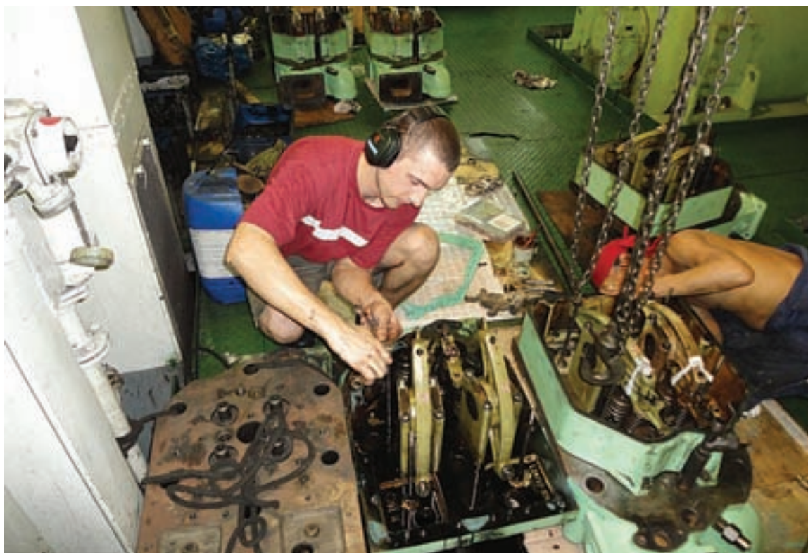
Rafał Tarka w maszynowni przy remoncie głowic prądotwórczych.
