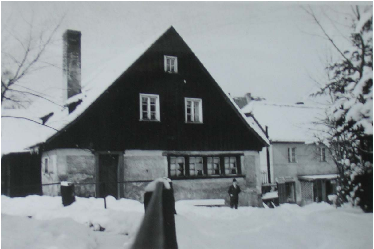
Die alte Glasschleife zu Hermsdorf, Gerichtsweg 19
