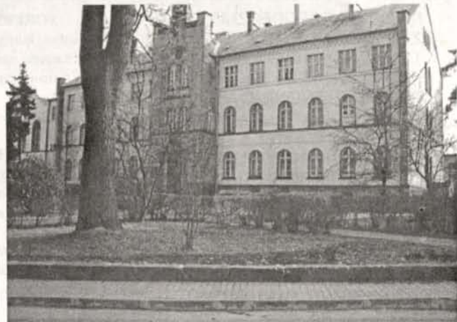
Budowa chodnika zakończyła się pół roku temu. Do tej pory ZBGKiM nie zdążył postawić ogrodzenia przy gimnazjum.
