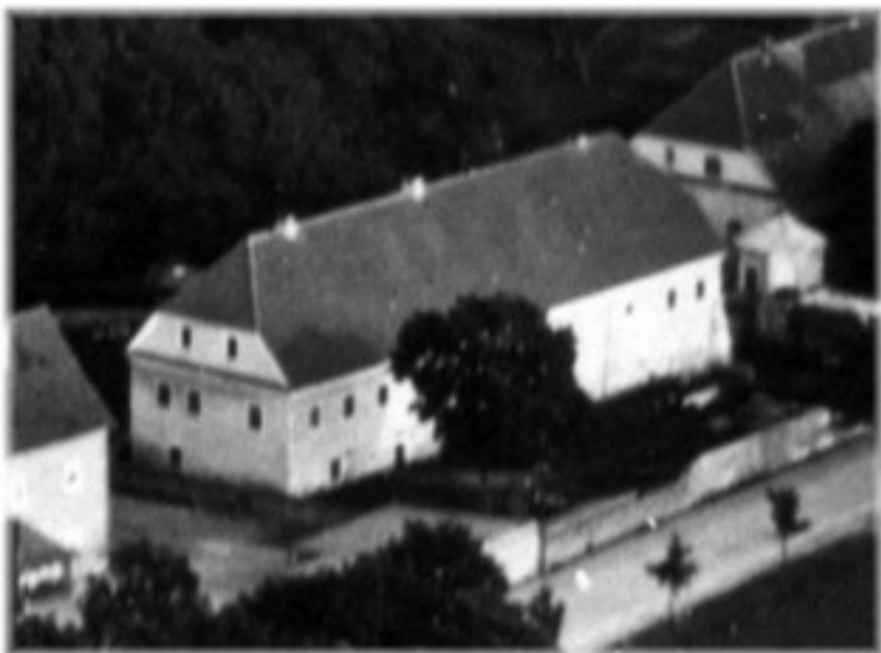
Ilustracja 42: Zbliżenie na północną i zachodnią elewację Długoego Domu.
