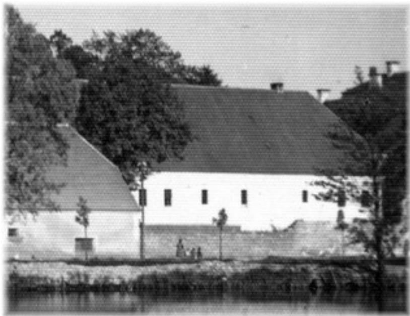
Ilustracja 34: Fragment przedstawiający zachodnią elewację Długiego Domu. Staw został dziś zasypany, natomiast po widocznych po lewej stronie dwóch budynkach nie dostrzeżemy już żadnych śladów.
