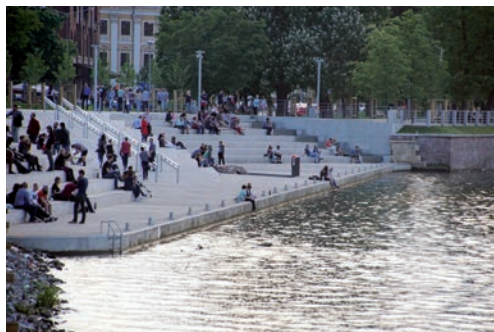
Bulwar Dunikowskiego po realizacji inwestycji – autor Bogdan Nowak
