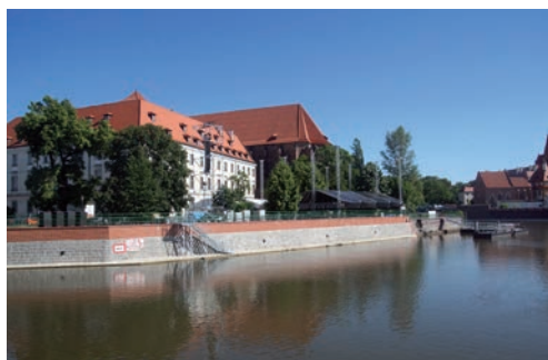
Wyspa Piaskowa po realizacji inwestycji – autor Bogdan Nowak
