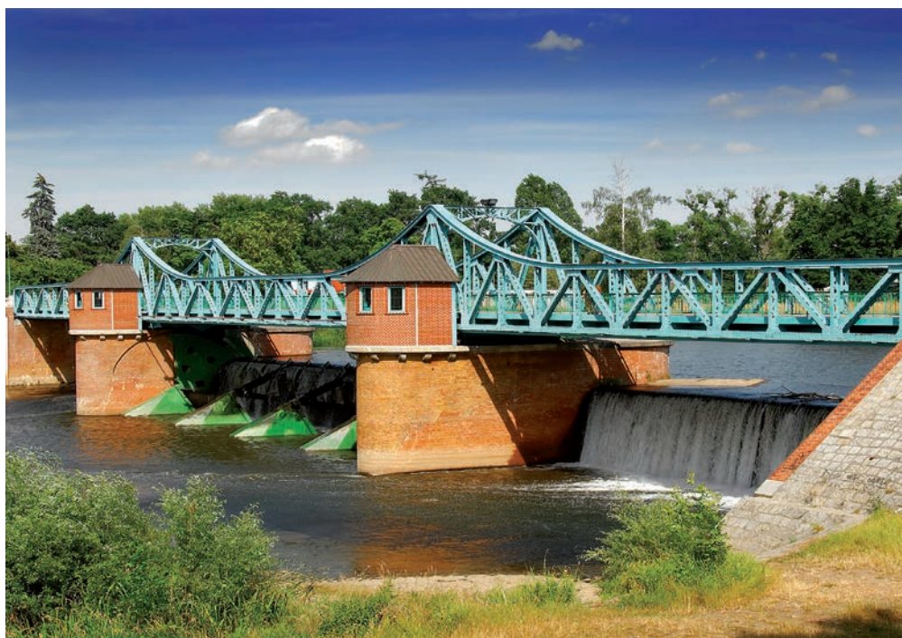
Jaz Bartoszowice na Kanale Powodziowym we Wrocławiu
