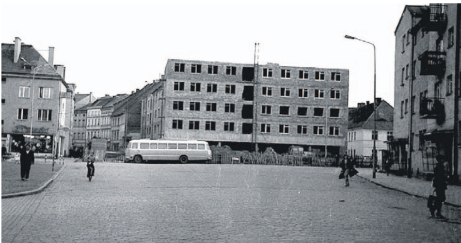
To samo miejsce patrząc z drugiej strony, też 1965 rok. Budynek w budowie na skrzyżowaniu ul. Brzeskiej i Ryнку, tu na parterze powstanie sklep meblowy
