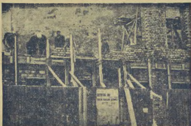
Warszawa odbudowuje się. — Budowa Ministerstwa Przemysłu przy Pl. Trzech Krzyży.
